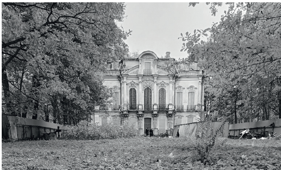
10 Собственная дача. Южный фасад 2023 Фотограф П. В. Николаенко Личный архив Т. Н. Носович
