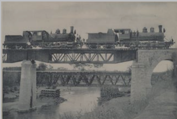
Испытание моста через реку Пухэ. 1900–е. ЦМЖТ РФ
