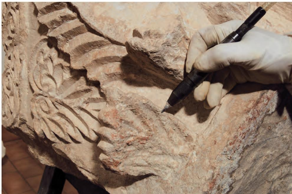
Илл. 40. Очистка поверхности, покрытой строительным раствором, с помощью виброгравера; мягкий известняк
