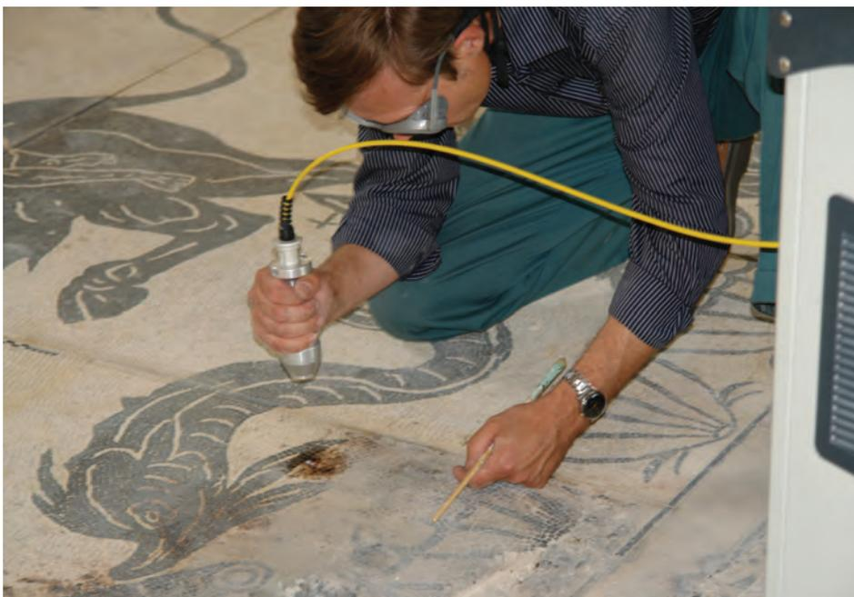
Илл. 74. Процесс лазерной очистки древнеримского мраморного пола
