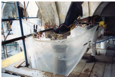
Илл. 38. Очистка распылением воды, плотный известняк
