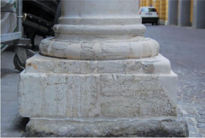
Илл. 42. Оштукатуривание трещин и заполнение пустот на поверхности; плотный известняк
