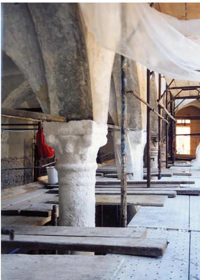
Илл. 39. Очистка с помощью компрессов с водным раствором гидрокарбоната аммония; плотный известняк
