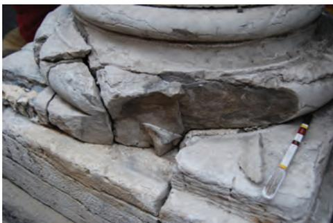
Илл. 37. Предварительное укрепление камня и установка подвижных фрагментов
