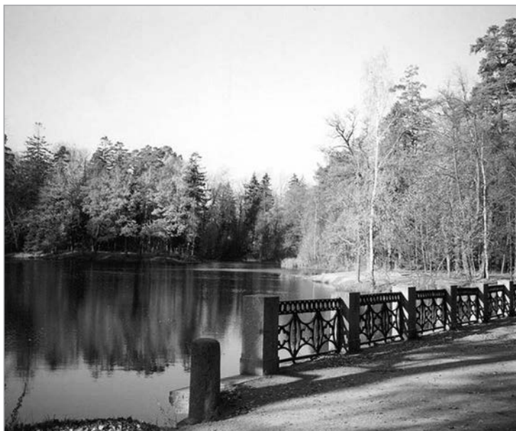
Плотина Большого пруда
